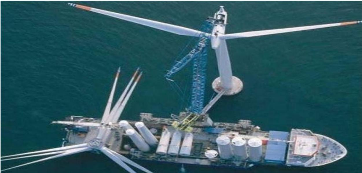
Ilustración 24 Buque A2sea. Realizando montaje en alta mar.
