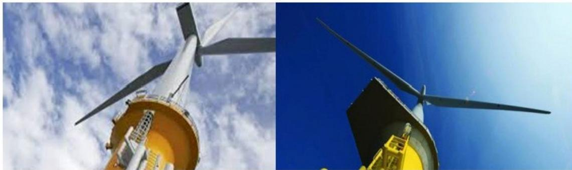
Ilustración 42 Distintas tipologías de plataformas exteriores en base en aerogeneradores offshore.
