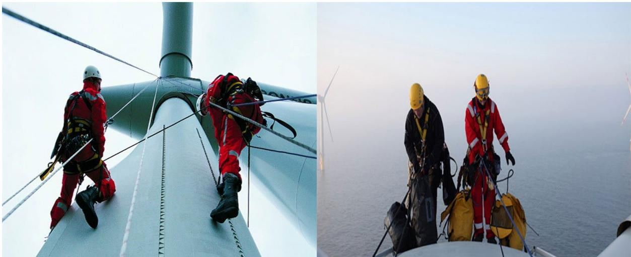
Ilustración 12 Labores de mantenimiento en altura
