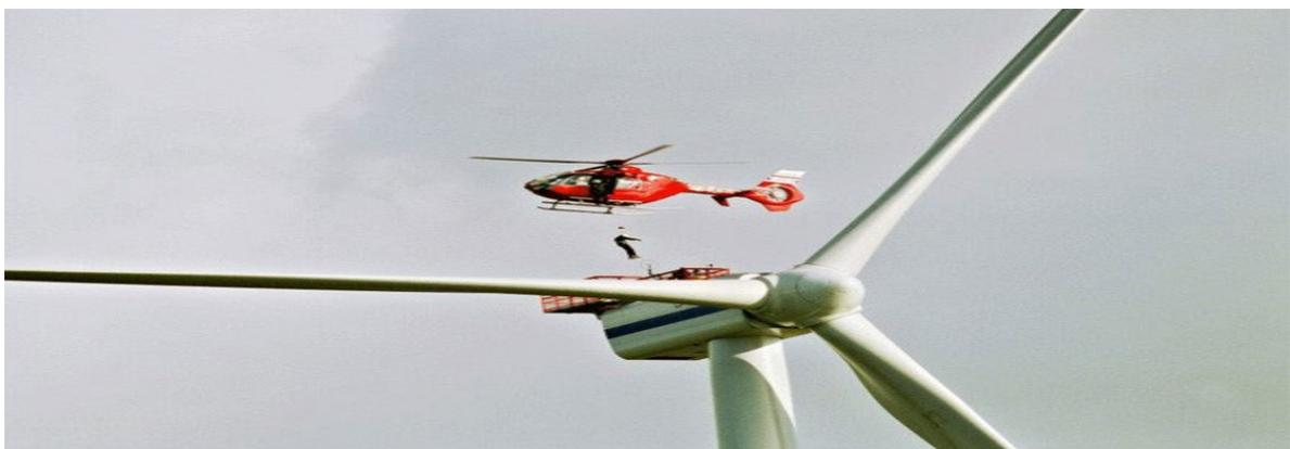
Ilustración 28 Desembarco de equipo de mantenimiento en la góndola del aerogenerador
