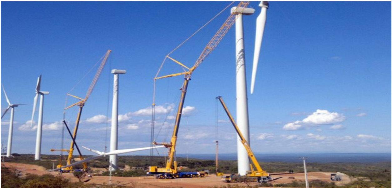
Ilustración 19 Grupo de grúas realizando montaje de parque eólico en tierra.
