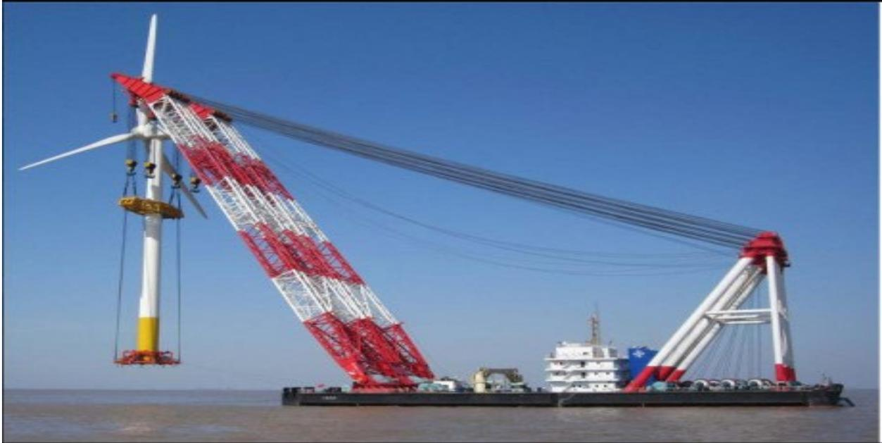
Ilustración 10 Barcaza grúa ubicando aerogenerador.
