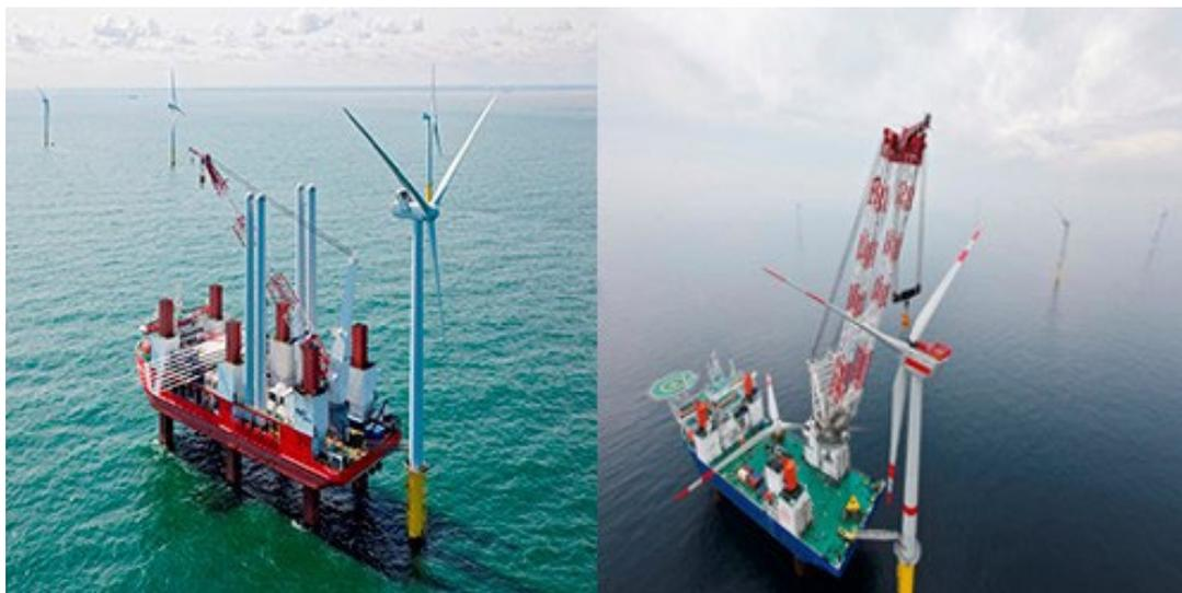
Ilustración 5 Mantenimiento MC3, sustitución de piezas grandes.
